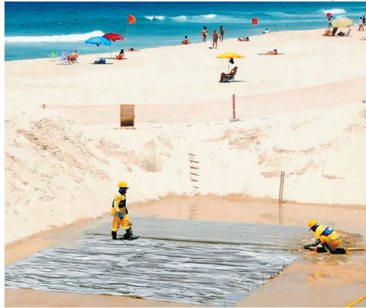
Obras na Praia da Barra deixaram comunidade científica indignada
